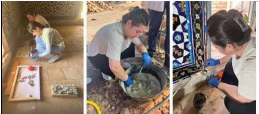
تصویر ۷ ملیکا بکنظروا، مرمطگر ازبک، در حال تمیز کردن قطعات کاشی بریده شده (چپ) و نارگیزا کالانداروا، در حال مخلوط کردن ملات از مصالح ساختمانی سنتی و قرار دادن آن برای تعمیر رج هندسی کاشی (وسط و راست).
