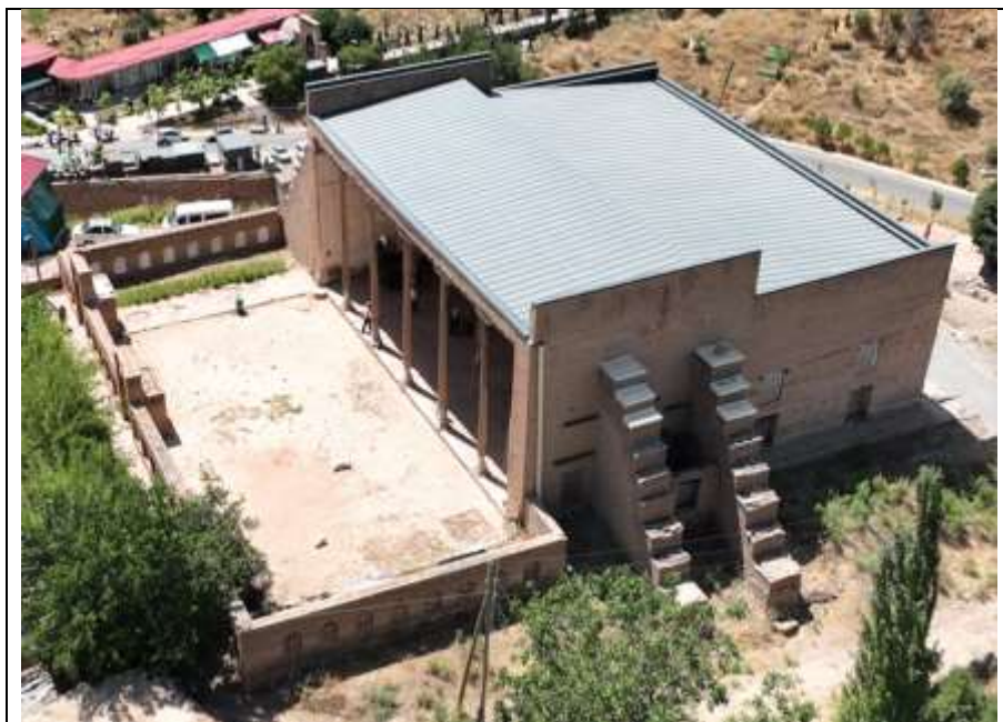
تصویر ۷. مسجد لنگر اوتا با سقف فولادی جدید، زهکش‌ها و کلاهک‌های فلزی باران روی پایه‌ها.
