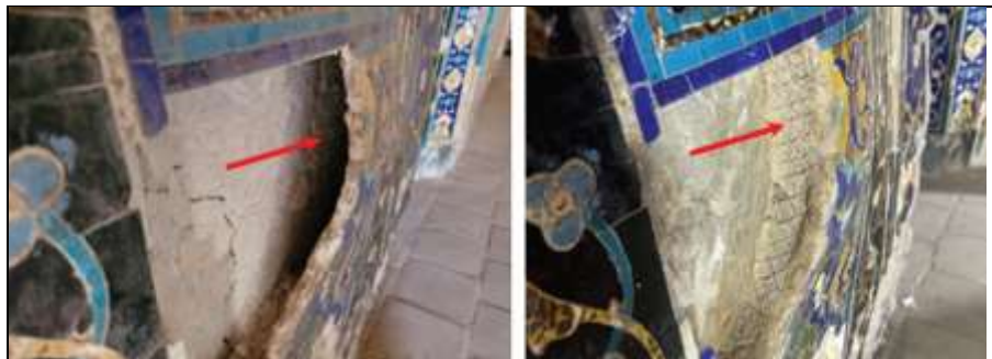
تصویر ۸. تثبیت بخش‌هایی از کاشی‌کاری‌های سست‌شده با پر کردن حفره‌های پشت آنها با اسفنج‌های آغشته به مواد تحکیم‌بخش و سپس آب‌بندی آنها با ملات ساخته شده از مصالح ساختمانی سنتی.
