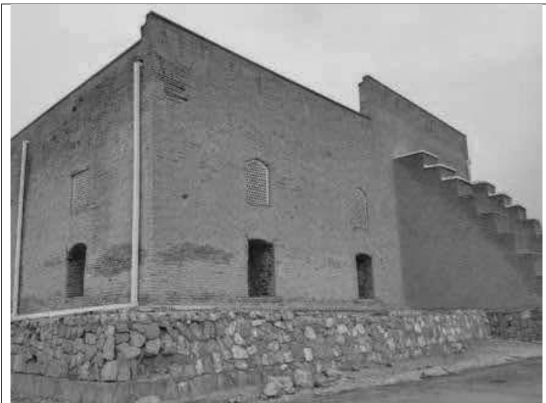
تصویر ۶ نصب سقف فولادی جدید، ناودان‌های با غلاف فولادی و لوله‌های زهکشی به همراه لوله‌های رابط برای انتقال آب از پایه‌های سنگی مسجد.
