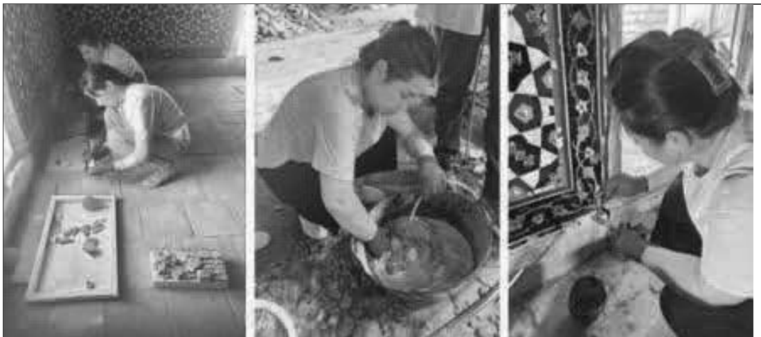
تصویر ۷ ملیکا بکنظروا، مرمتگر از بک، در حال تمیز کردن قطعات کاشی بریده شده (چپ) و نارگیزا کالانداروا، در حال مخلوط کردن ملات از مصالح ساختمانی سنتی و قرار دادن آن برای تعمیر رج هندسی کاشی (وسط و راست).
